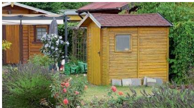
Separate Schuppen sind unzulässig. Ist die Laube kleiner als 24 m 2 , kann ggf. an die Laube ein Schuppen angebaut werden (Bauantrag).
